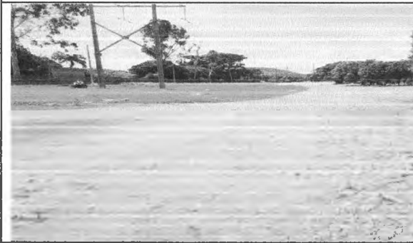
Aspecto del tramo carrera 38 lote N°4
