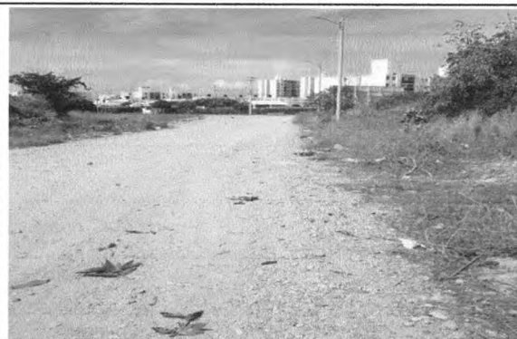
Aspecto tramo de la vía carrera 30
