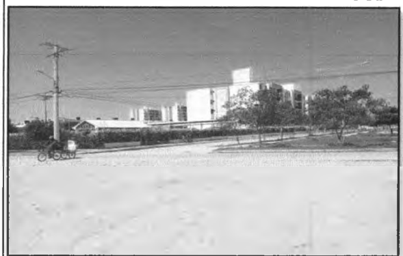
Tramo de la carrera 30 intersección calle 3N
