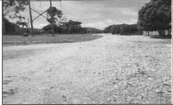
Vista tramo carrera 38 tomada mas al sur
