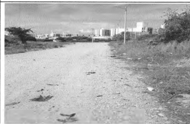
Aspecto tramo de la vía carrera 30
