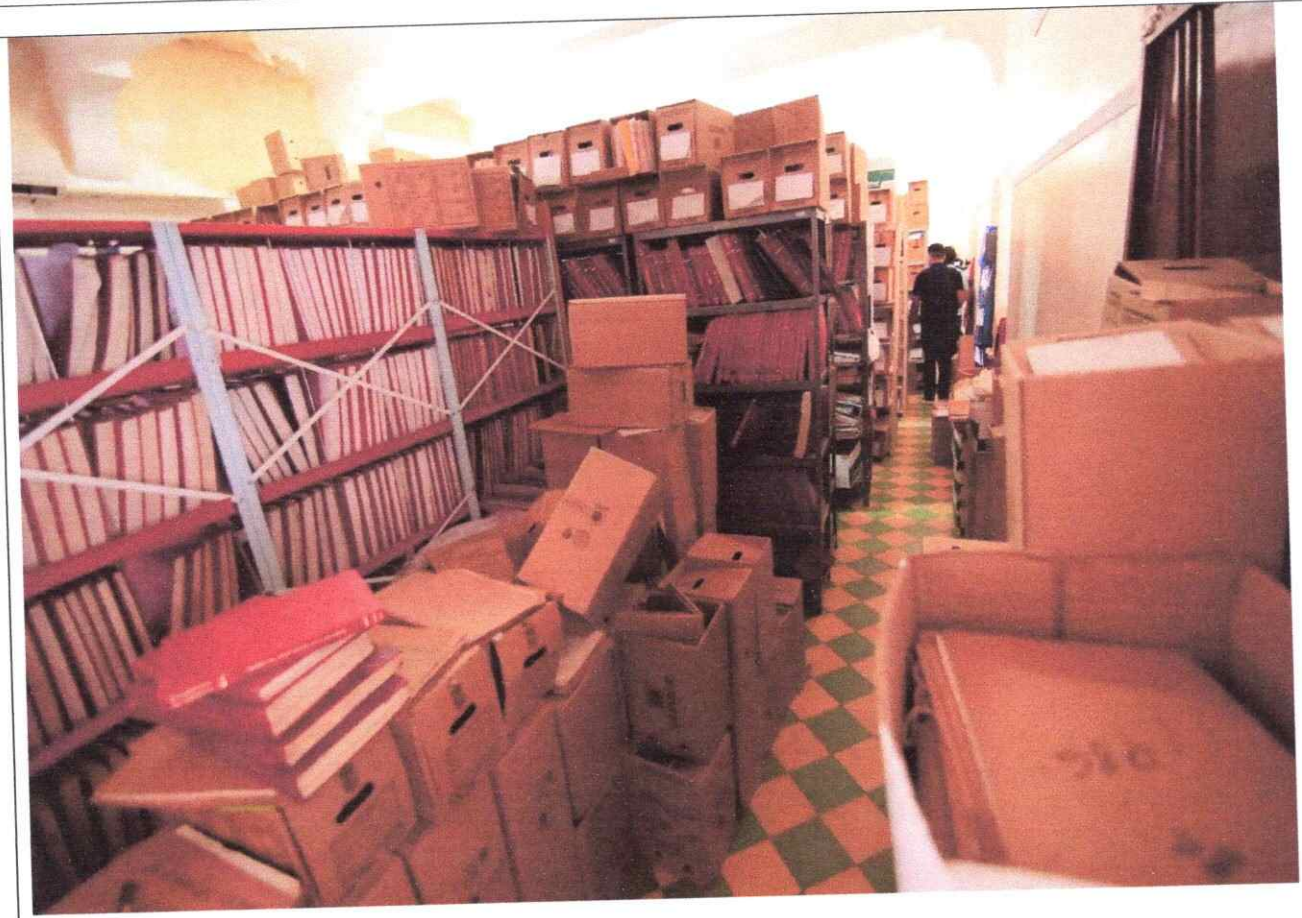
El palacio municipal actual, por ser un edificio antiguo, presenta problemas por su visible deterioro en techos, paredes, pisos, escaleras, en fin, en toda su infraestructura, además del hacinamiento existente, considerándose un riesgo para los funcionarios que allí laboran, pues en cualquier momento puede ocurrir un accidente laboral.
