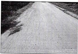
Fotografía 1, Patología en carpeta asfáltica tipo piel de cocodrilo masiva con asentamiento diferencial en el borde.
