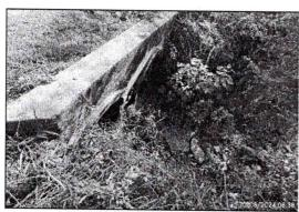
Fotografia 7, Taponamiento y obstrucción de alcantarillas.
