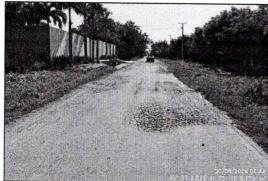
Fotografia 3, Patología en carpeta asfáltica tipo piel de cocodrilo con presunta falla de la estructura de pavimento.
