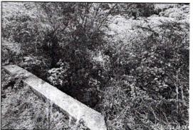
Fotografía 8, Taponamiento y obstrucción de alcantarillas.
