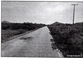
Fotografía 5, Patología en carpeta asfáltica tipo piel de cocodrilo concentrada en un solo punto. Sector priorizado para realizar mantenimiento con actividad tipo bacheo.
