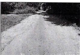
Fotografía 4, Desprendimiento de la carpeta asfáltica en ambos bordes de la vía.
