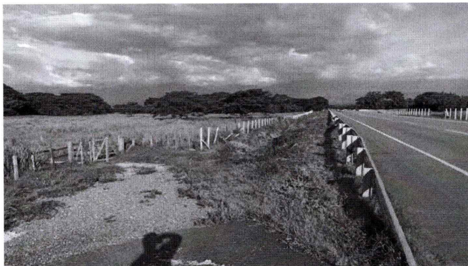
AVENIDA AEROPUERTO TRAMO GLORIETA LA PAZ INVIAS – HACIA CARRERA 4 CON 44
